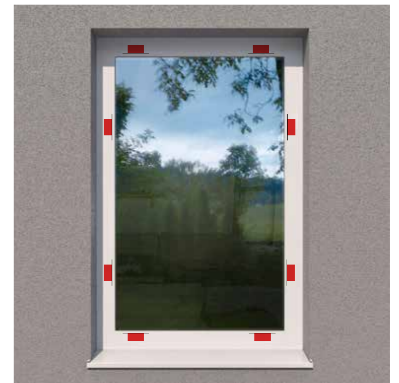
Standardmäßige Anordnung der I-tec Secure Verriegelungspunkte
